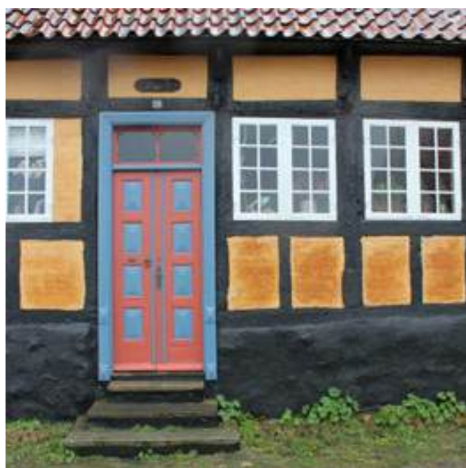
Overgade 29, opført 1700-tallet, fredet. Det rige bindingsværk med kalkede tavl, den høje sorttjærede sokkel og det teglhængte tag er karakteristisk for Ebeltoft.
