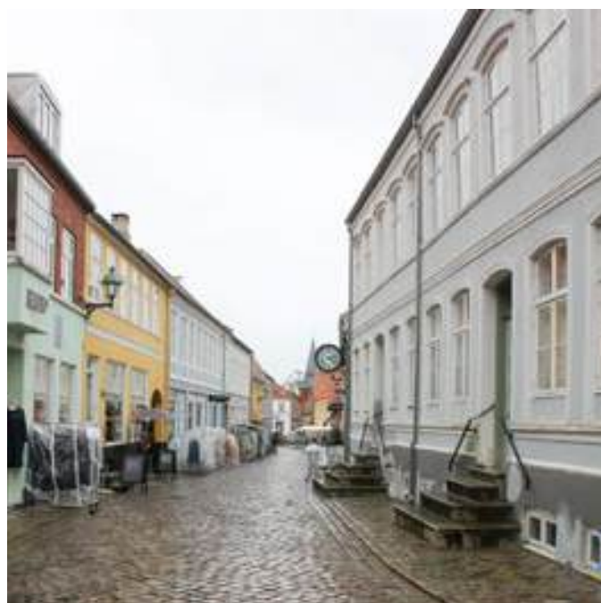
Grundmuret forhus i 14 fag til højre i billedet - del af en tidligere købmandsgård, Adelgade 39-41, opført 1854, fredet.
