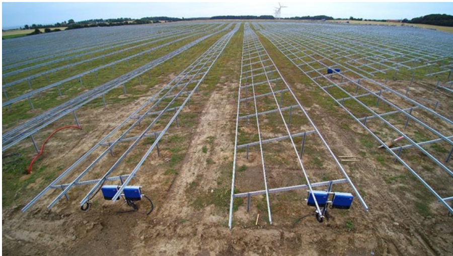
Aluminiumsstativer påsat invertere (blå)
