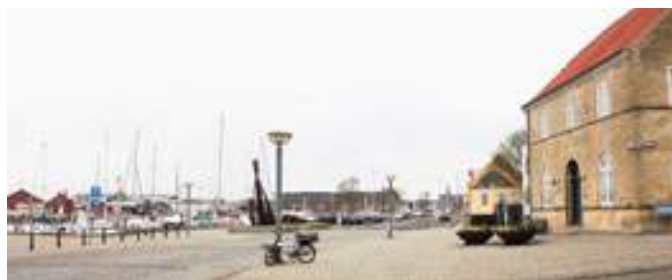
Faaborg Havn med toldpakhuset fra 1838 i højre side af billedet, fredet.
