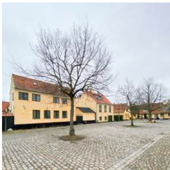
Fogedens Plads, hvor et af de såkaldte skipperhuse til venstre i billedet er med til at danne ramme om pladsen. Hovedhuset på Fogedens Plads 2B, opført ca. 1780 af Johan H. Blichmann, repræsenterer byens gennemgående enkle byggeskik.
