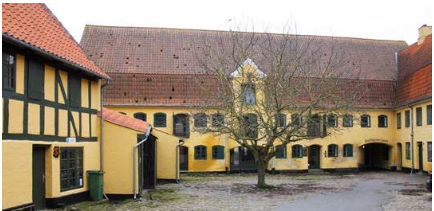
Voigts Gård med det sammenbyggede pakhus og sidehus fra 1837, begge fredede. De åbne porte skaber fri passage mellem Vestergade og videre ned i retning mod vandet og giver på den måde et indblik i den tidligere købmandsgårds anseelige størrelse.
