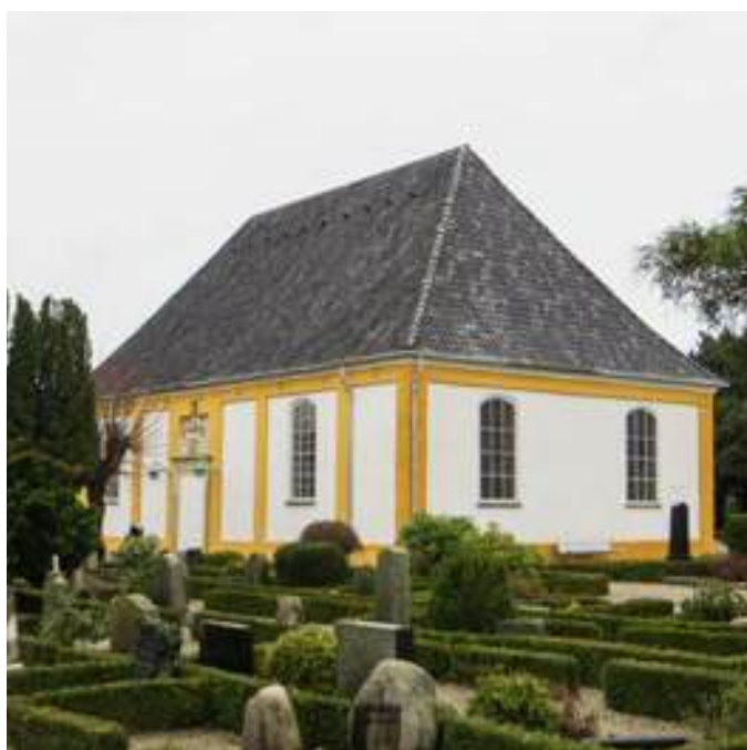
Reformert Kirke og kirkegård, Dronningensgade 87 B, opført 1735, fredet. Ligesom reformert skole og præstegård vidner de om et af byens særlige privilegier, religionsfriheden, som tiltrak borgere med forskellig tro fra hele Europa.
