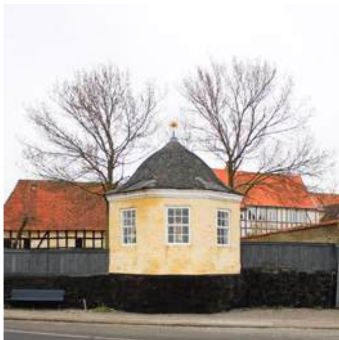
Lysthus fra starten af 1800-tallet som del af Den Gamle Gård i baggrunden, forhuset i Holkegade fra 1700-tallet, hele anlægget er fredet.
