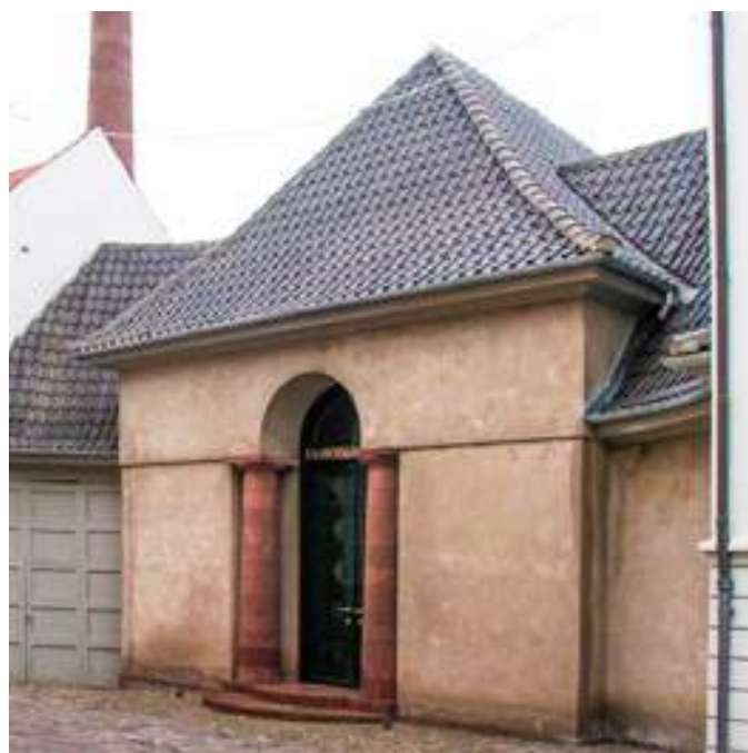
Faaborg Museum, Grønnegade 75, opført 1915 af fabrikant Mads Rasmussen og tegnet af arkitekt Carl Petersen, fredet. Trods den beskedne størrelse fremstår facaden monumental og viser nyklassicismens arkitektoniske virkemidler.
