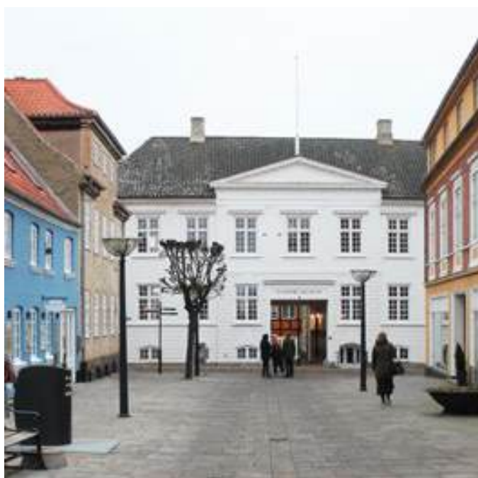
Østergade afsluttes af det statelige forhus til Mads Rasmussens Gård, nr. 45, opført 1844, fredet. Den monumentale, symmetriske facade repræsenterer den klassicistiske stil, som er fremtrædende flere steder i bybilledet.
