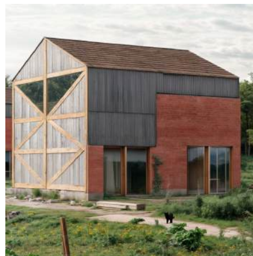
Neobindingsværk. Robust træramme er et fleksibelt skelet, hvor genbrugsmaterialer kan indkorporeres. Det muliggør brugen af varierende teknikker og materialer, samtidig med at der opretholdes en modulær logik, så husene løbende kan ombygges. Peter Allan Klode Gustafson, Asferg skovbjerg Leick
