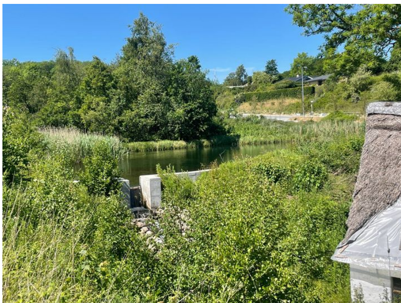
Stemmeværket, eller muren, der holder vandet inde i mølledammen, er blevet toprenoveret efter den styrtede sammen i 2019. Foto: Anne Frank Henriksen
