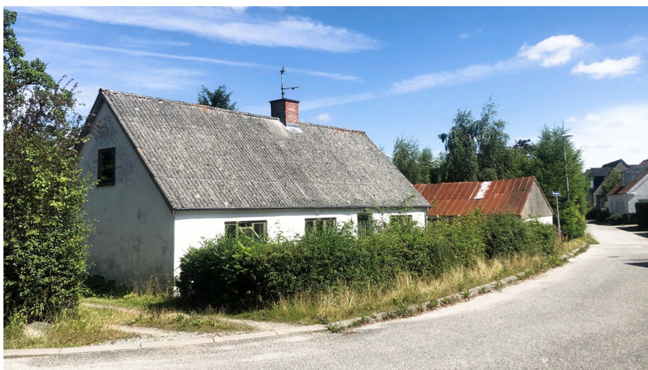
ØSTERGÅRDSVEJ 1 | STUEHUS OG UDHUS
