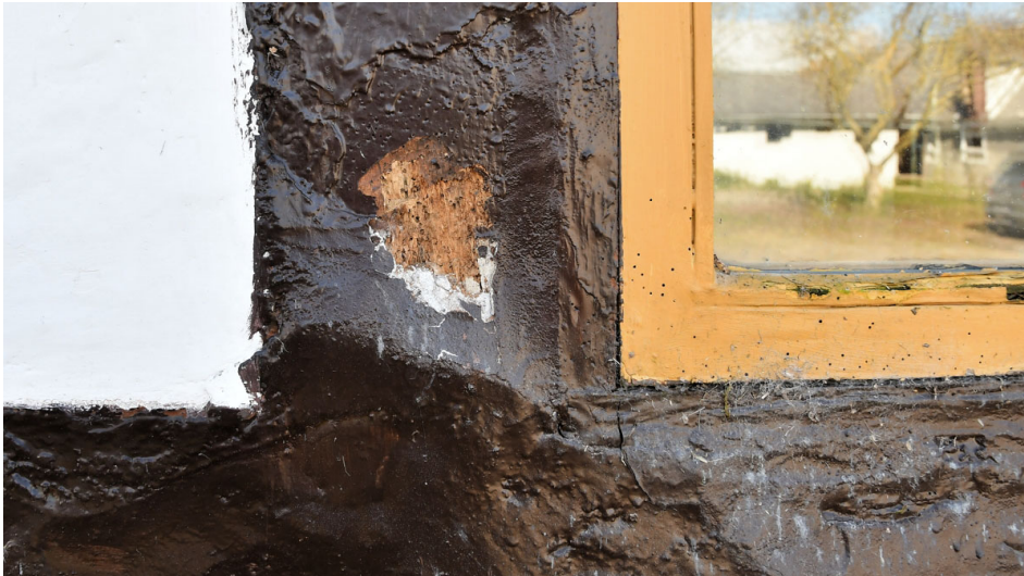
SKELLERUPVEJ 9 | STUEHUS 2025 | BINDINGSVÆRK OG VINDUE
