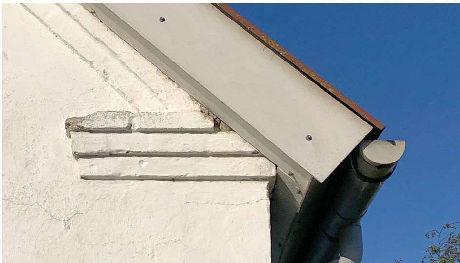
PAKHUSVEJ 13 | NYT UDHÆNG
