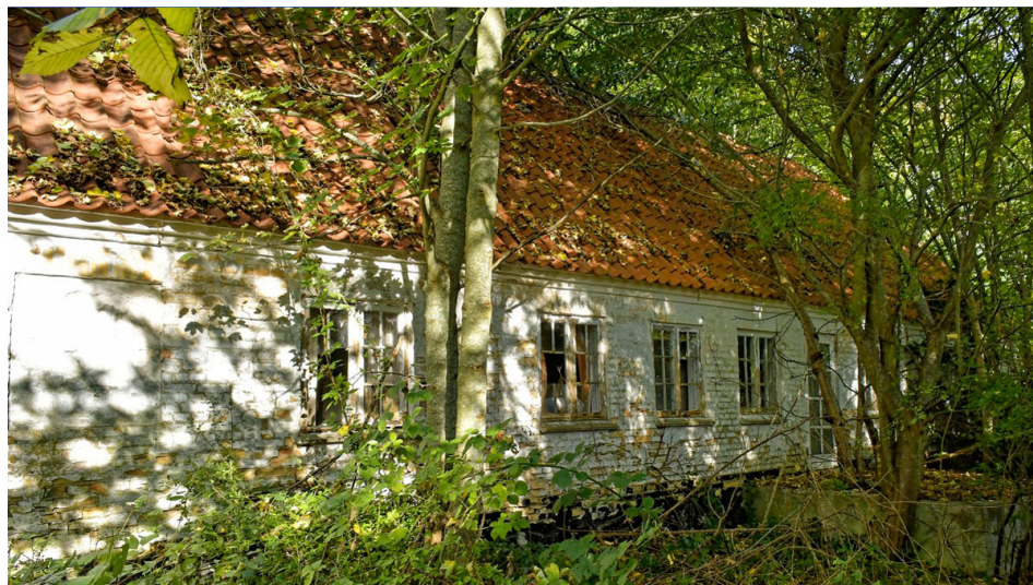
VIBROGAARD OKTOBER 2020 | STUEHUS FACADE MOD SYD
